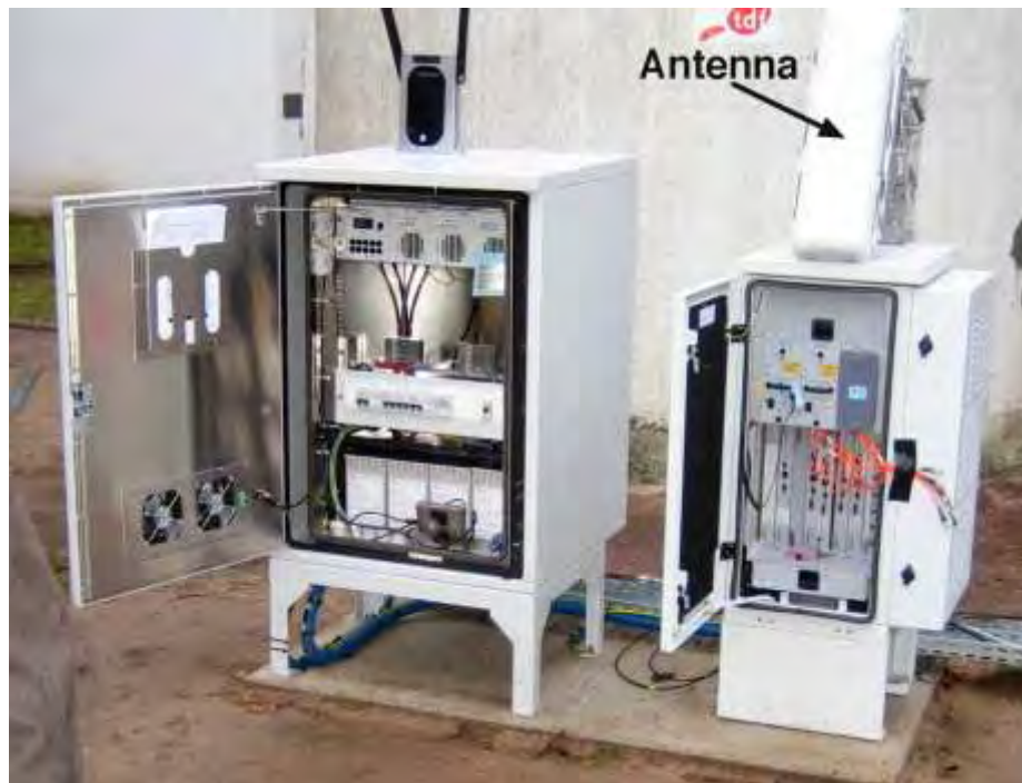
Figure 14. Example of a WiMAX base station transmitter (photo by Groupe Aménagement Numérique des Territoires, licensed under Creative Commons Attribution 2.0 Generic license).
